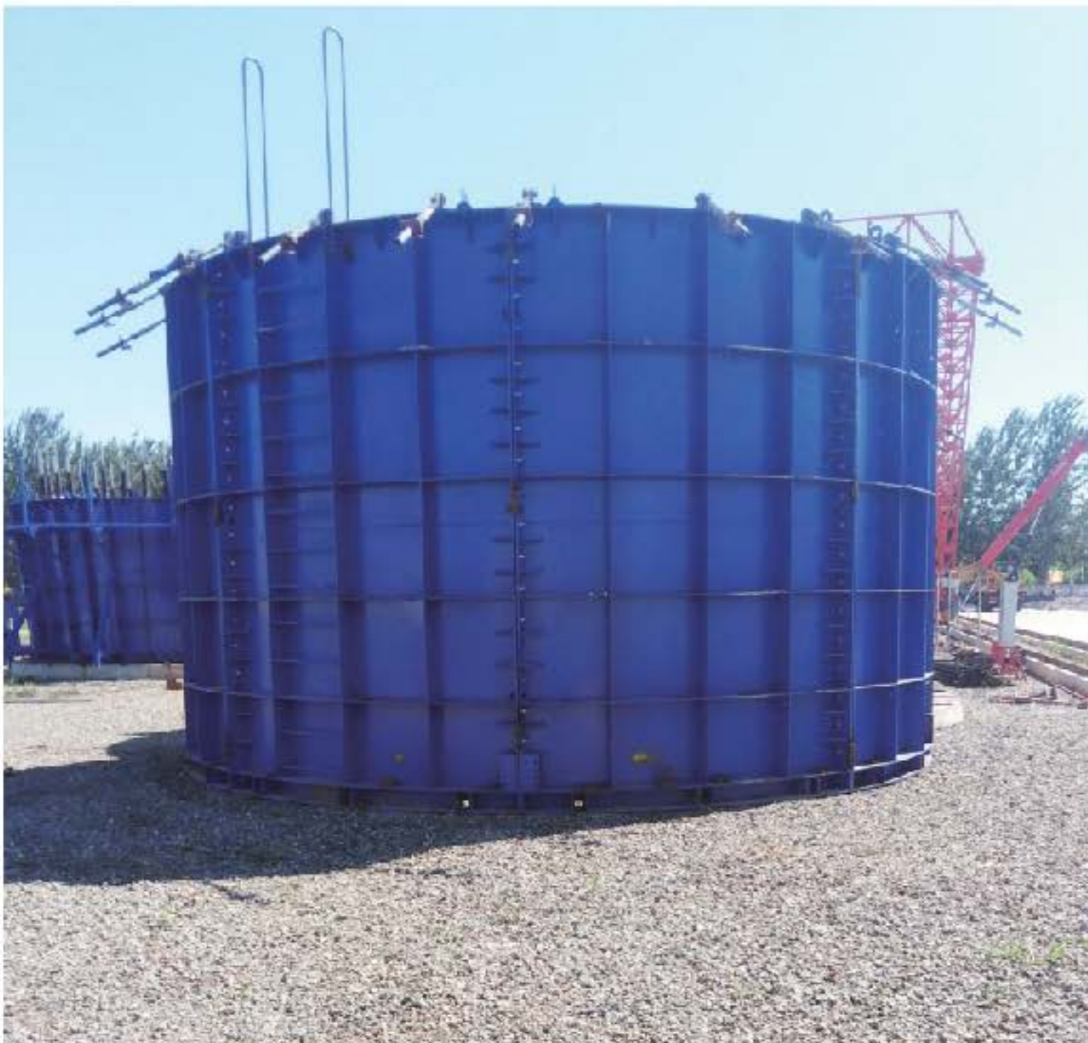
锥筒形塔筒模具 Conical tower mould
